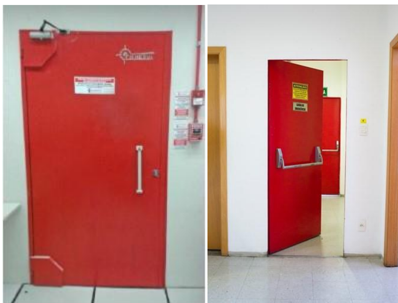
Figura 11: Vistas genéricas interna e externa porta corta fogo.
